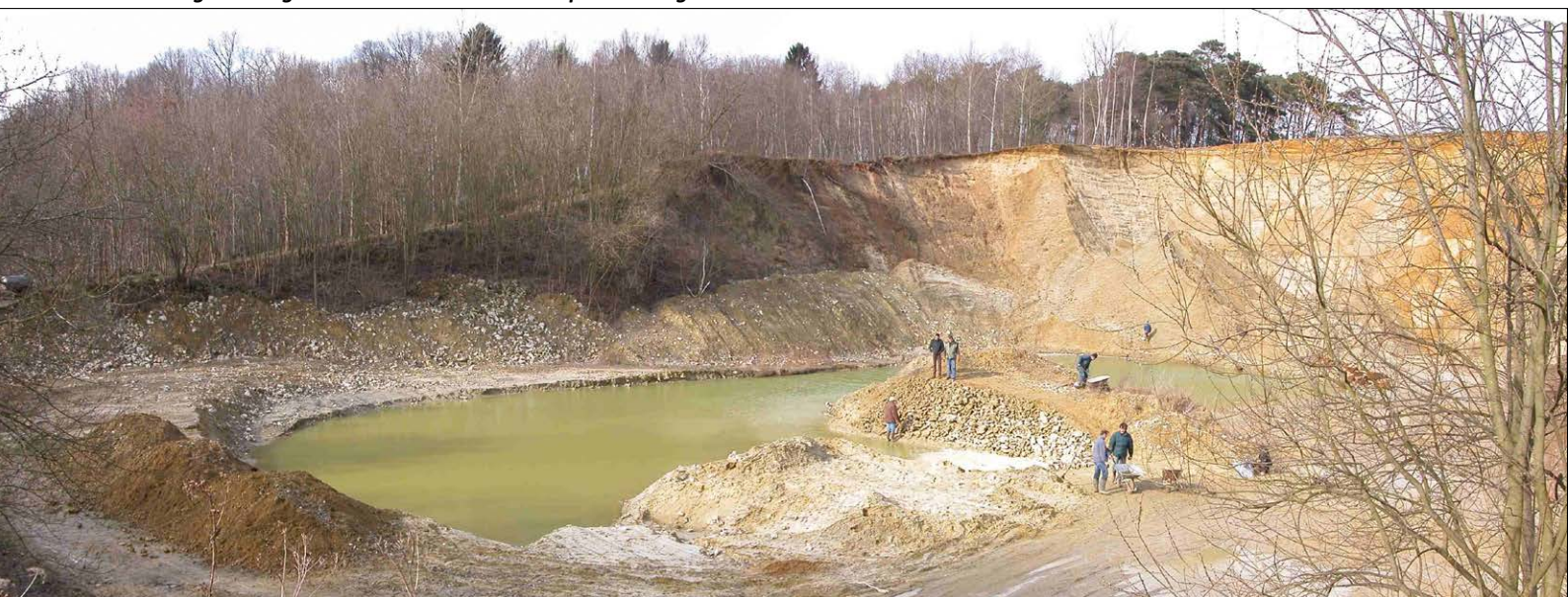
Inrichting van de groeve voor de vroedmeesterpad. Aanleg van het schiereiland. Foto Mark Lehouck
