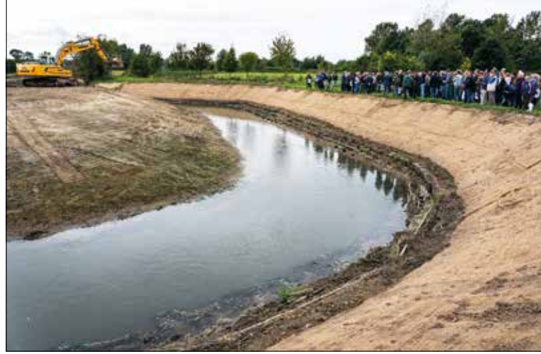
■ Demerdag. Nieuwe meander in aanleg op de Kleine Gete in Wange. Foto RLZH
