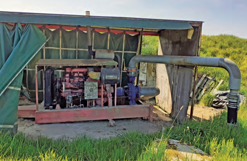
■ Waterpomp om een groot wachtbekken te vullen. Onaanvaardbare praktijk.
